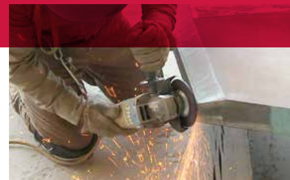
Desbaste de una plataforma como preparación para soldadura.
