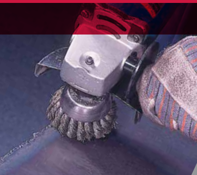
Eliminación de escoria de una placa de acero cortada con llama.
