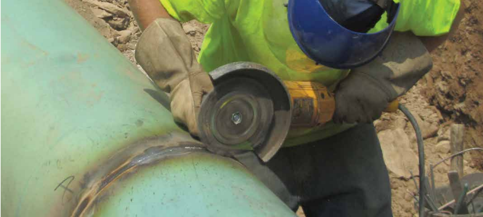
Limpieza de soldadura de pase de raíz en tendido de tubería.
