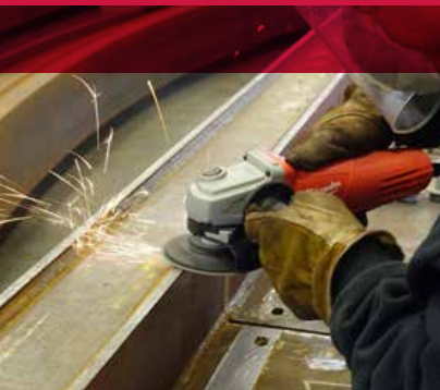
Acabado de rieles metálicos con fibrodisco.
