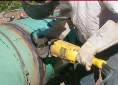
Limpieza de soldadura en unión de tubería
